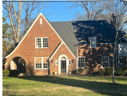
B. 310 Lynnwood Blvd
