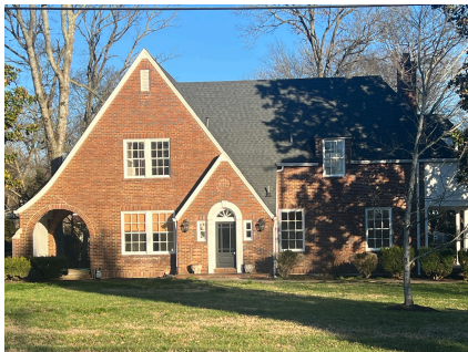
B. 310 Lynnwood Blvd
