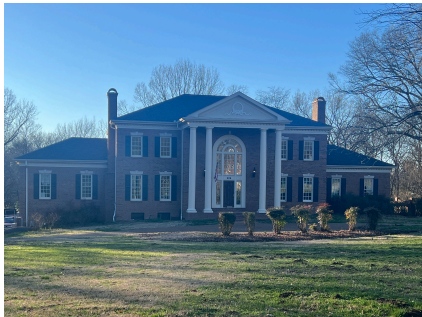
C. 309 Lynnwood Blvd
