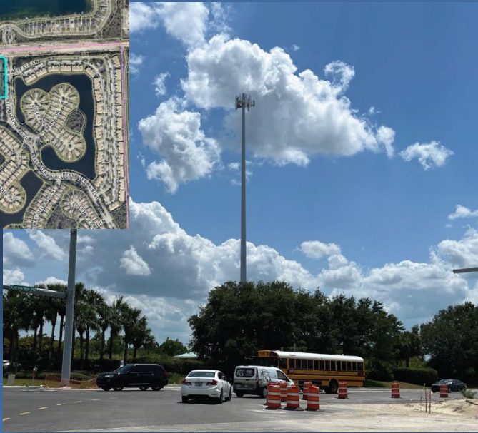
Bella Terra 175-foot Monopole
